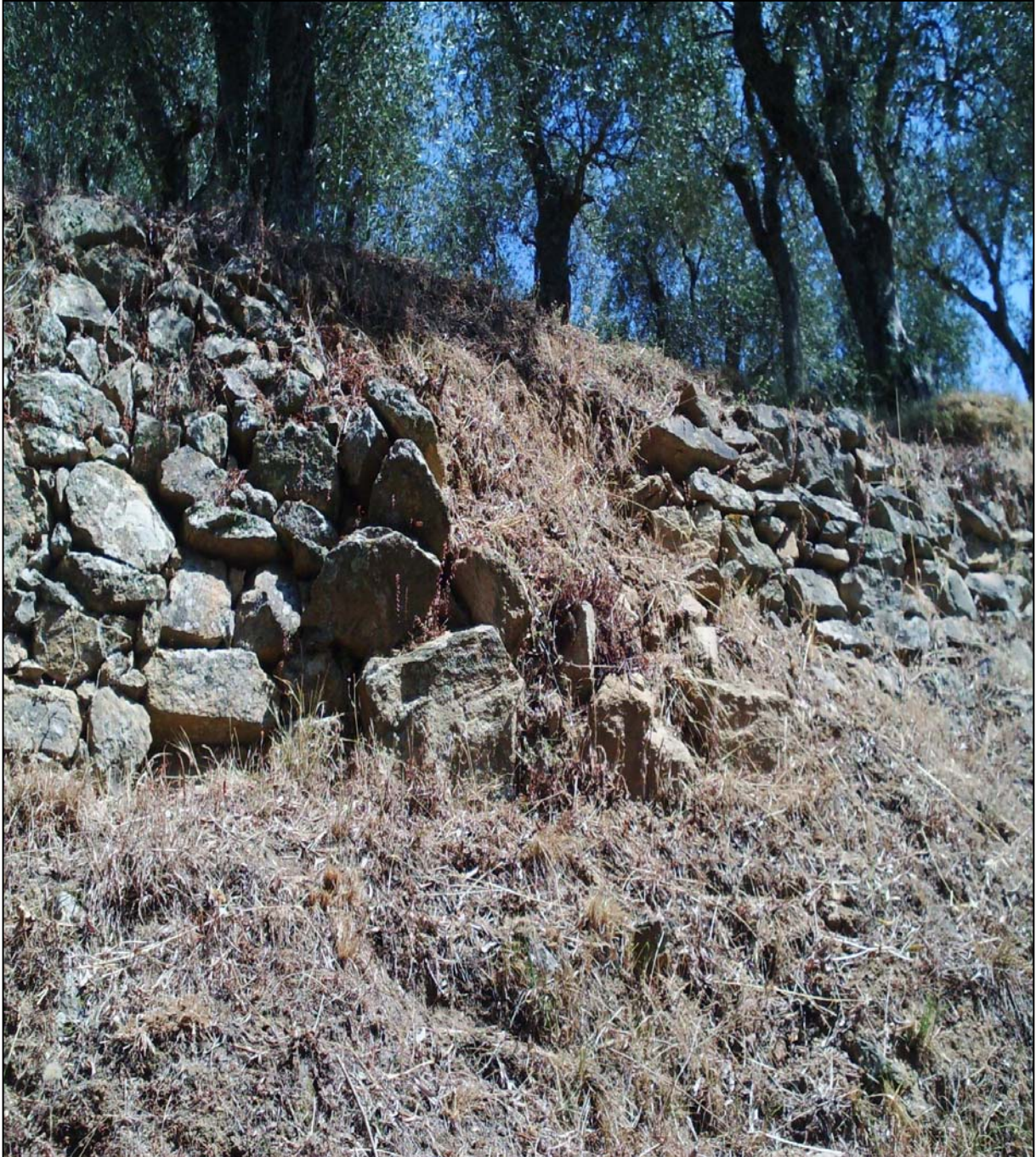
Crollo di muri a secco in oliveto causato da cinghiali
