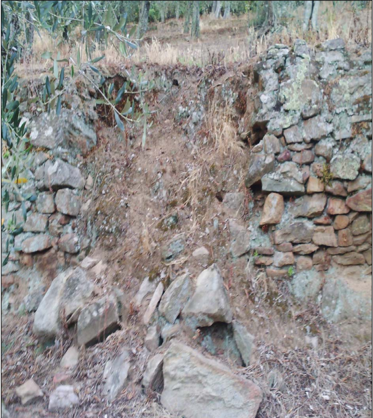
Danni da cinghiali a muro a secco (Monte Castellare)
