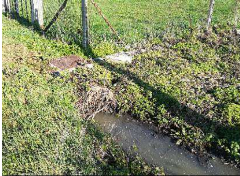
Foto n°1 - Vista dello scarico dell'area A
