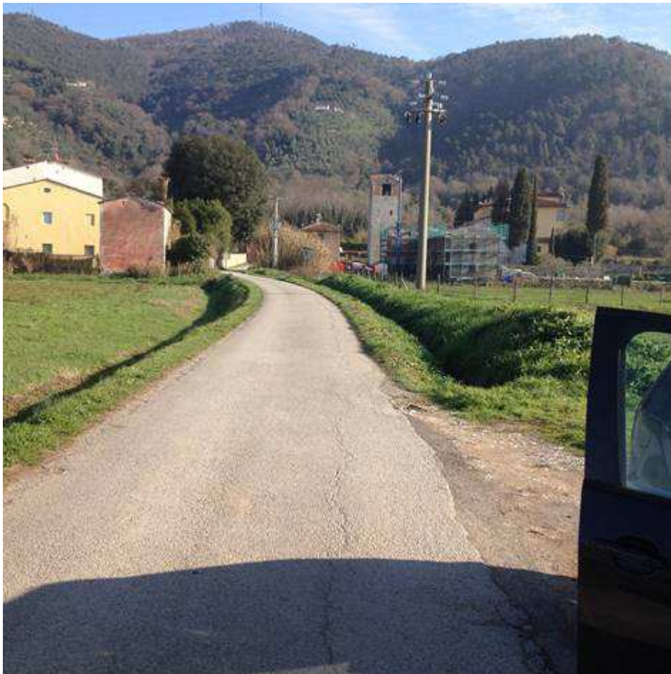
Foto n°2 – Percorrenza fognatura di progetto lungo strada asfaltata
