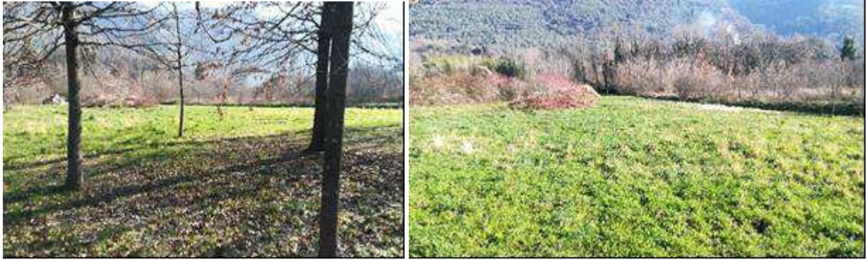
Foto n°7 – Vista dell'area individuata per realizzazione impianto di fitodepurazione
