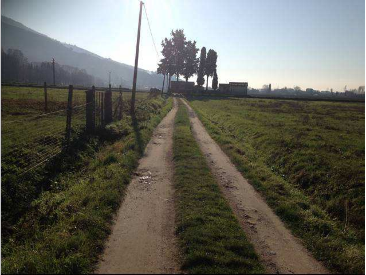
Foto n°3 - Percorrenza fognatura di progetto lungo strada sterrata e sulla destra fosso per recapito troppo pieno stazione di sollevamento
