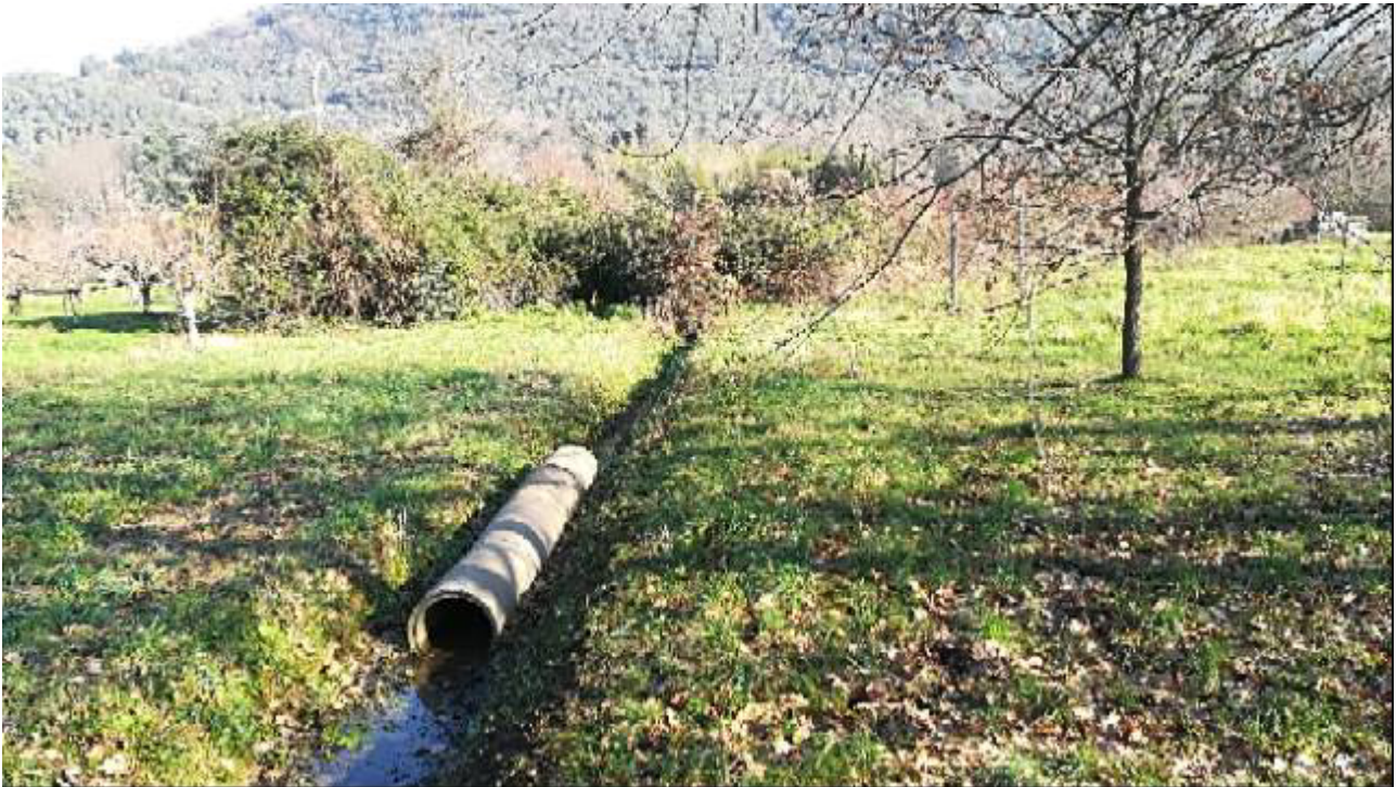
Foto n°4 – Vista dello scarico dell'area B
