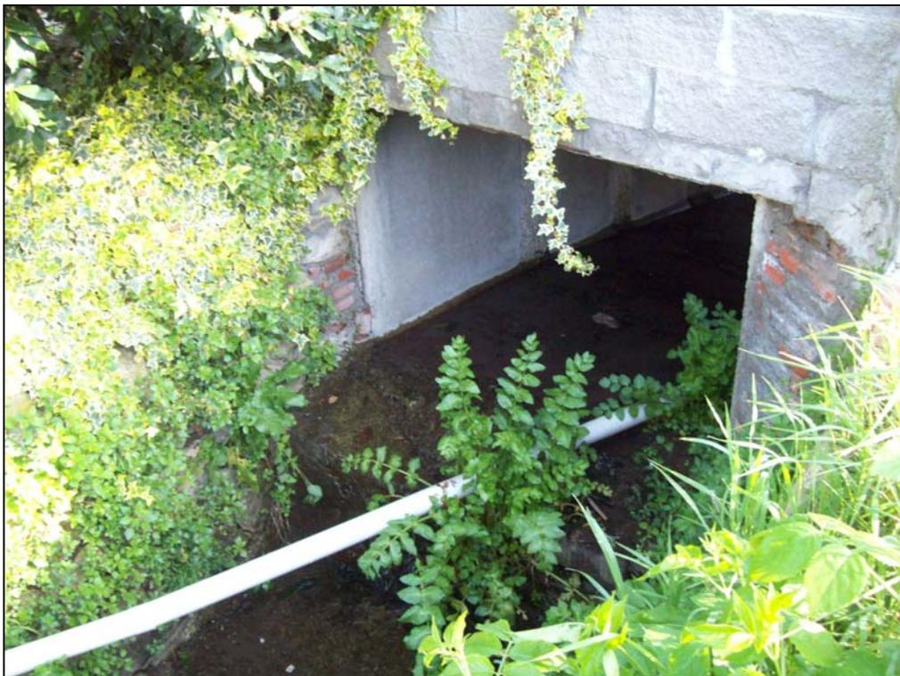
*Foto 4 – Bocca d'uscita del tratto tombato di foto 3, è visibile un tubo di captazione delle acque del fosso*
