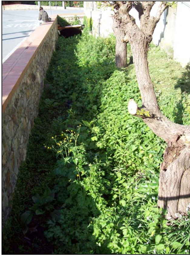
Foto 3 – Tratto dell'alveo cementificato e ricoperto da vegetazione
