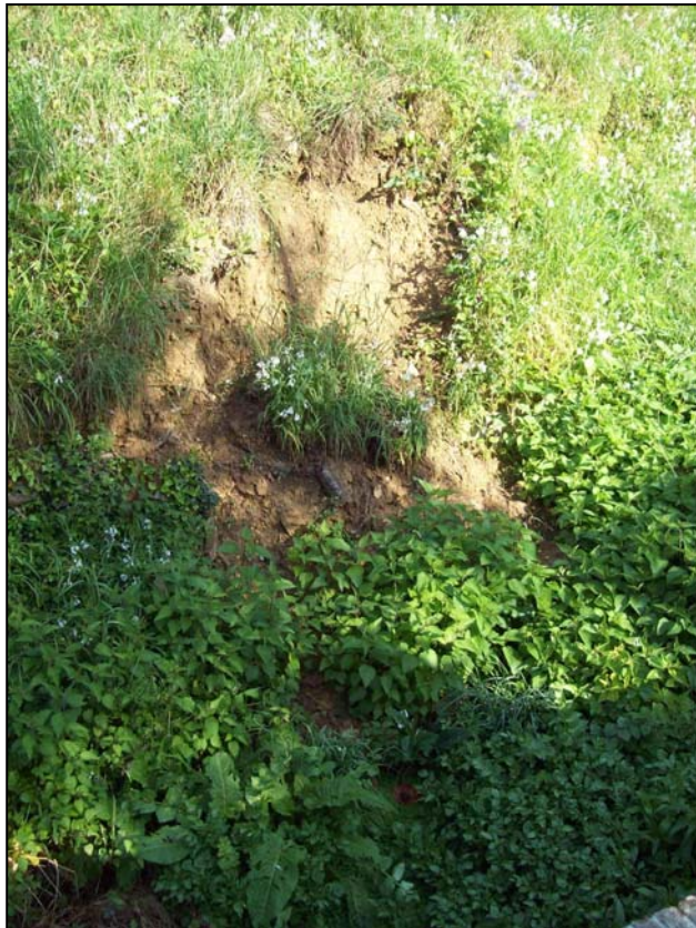
Foto 4 – Modesto smottamento di terreno sulla destra
