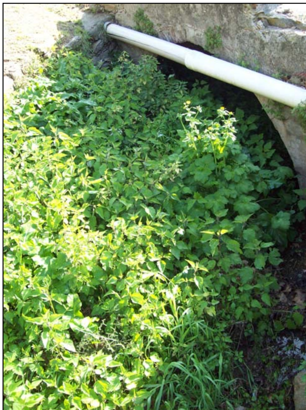
Foto 1 – Attraversamento di Via del Falcione ostacolato dalla vegetazione
