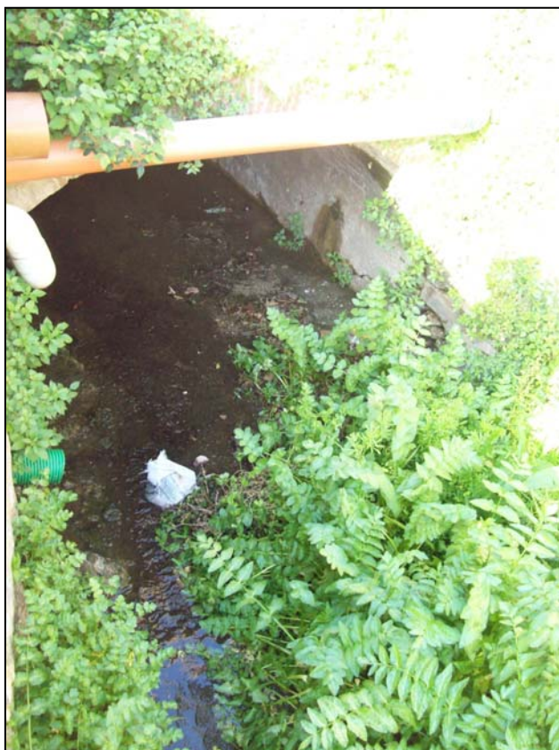
Foto 6 – Modesto smottamento di terreno sulla destra
