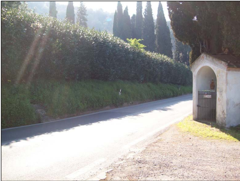
Foto 1 – Sulla sinistra della foto il tratto finale tubato del Botro Bartole
