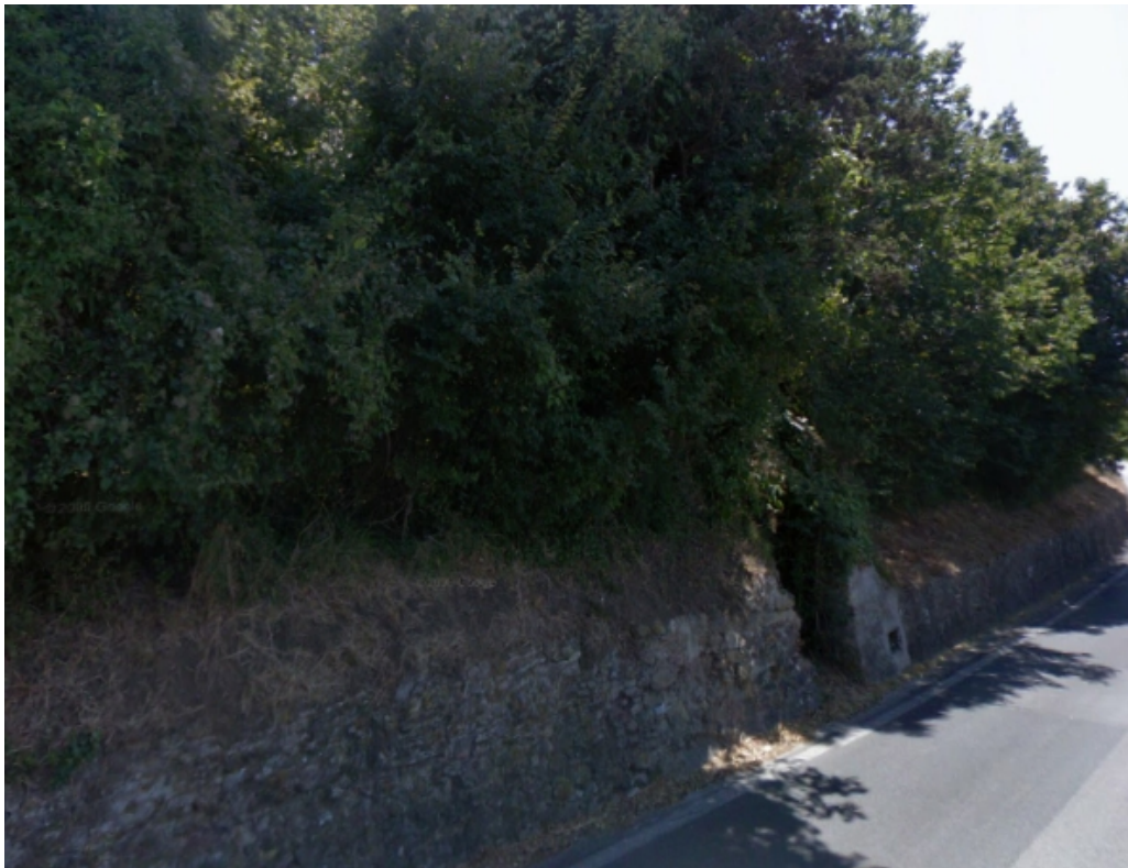
Foto 4 – tratto finale su Via del Brennero a sud della Villa Agostini
