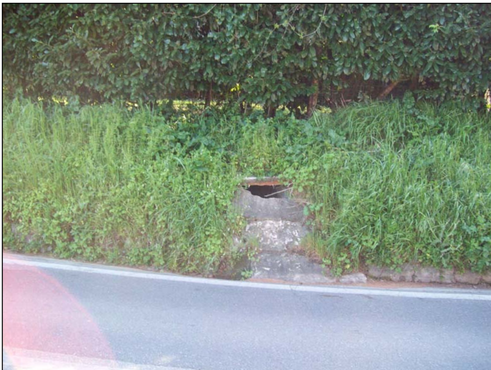
Foto 2 –Il tratto finale tubato del Botro Bartole, particolare
