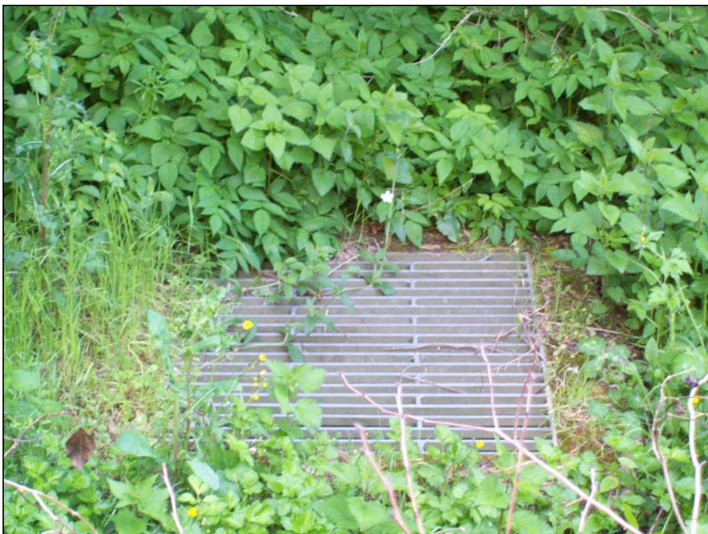
Foto 2 – Tratto dello scolo di Rigoli intubato, particolare
