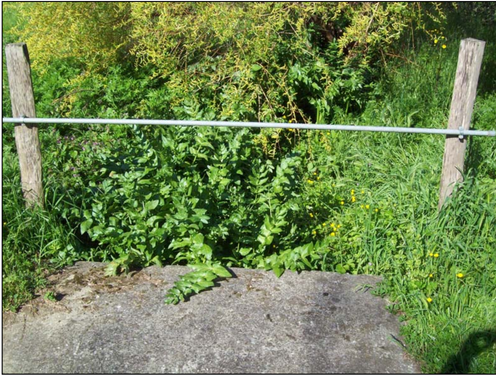
Foto 3 – Alveo dello scolo completamente ricoperto da vegetazione
