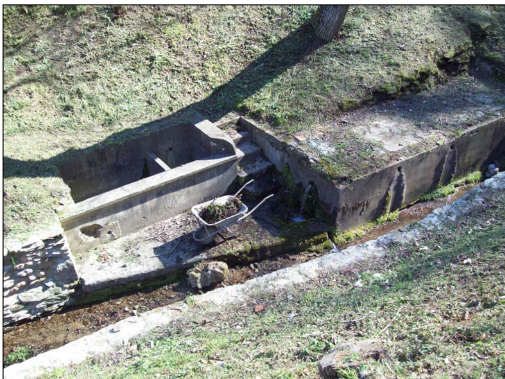
Foto 4 – Cisterna di raccolta presente sul lato destro del rio
