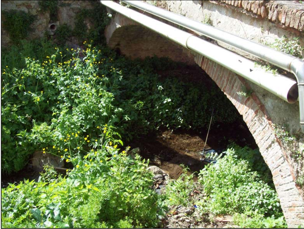
Foto 5 – Presenza di vegetazione nell'alveo dello Zambra a sud del ponte di via Barachini
