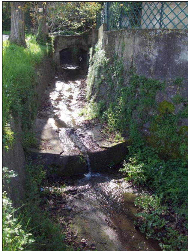
Foto 2 –Alveo e sponde del botro cementificate
